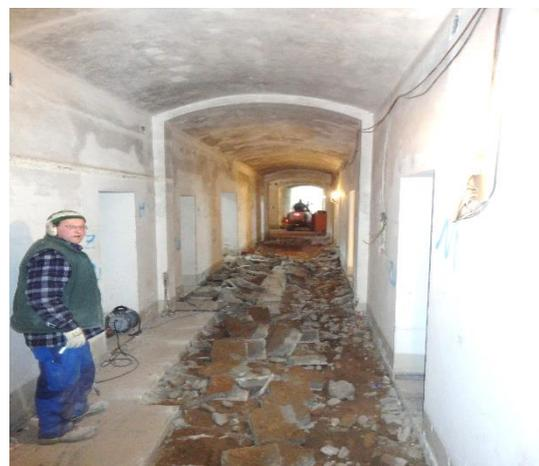
Ausbau des Fußbodens im Erdgeschoss zur Verlegung der Schmutzwasserleitung
