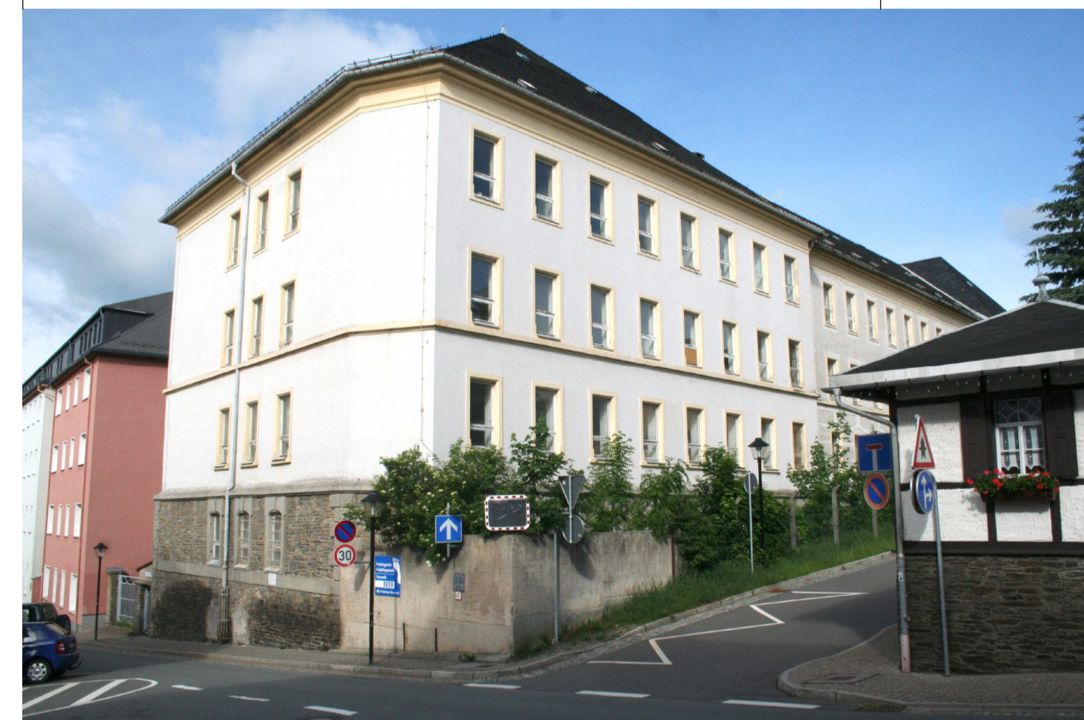
Gebäude vor Sanierungsbeginn
