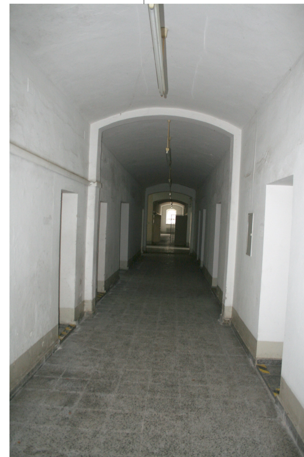
Gebäude vor Sanierungsbeginn
