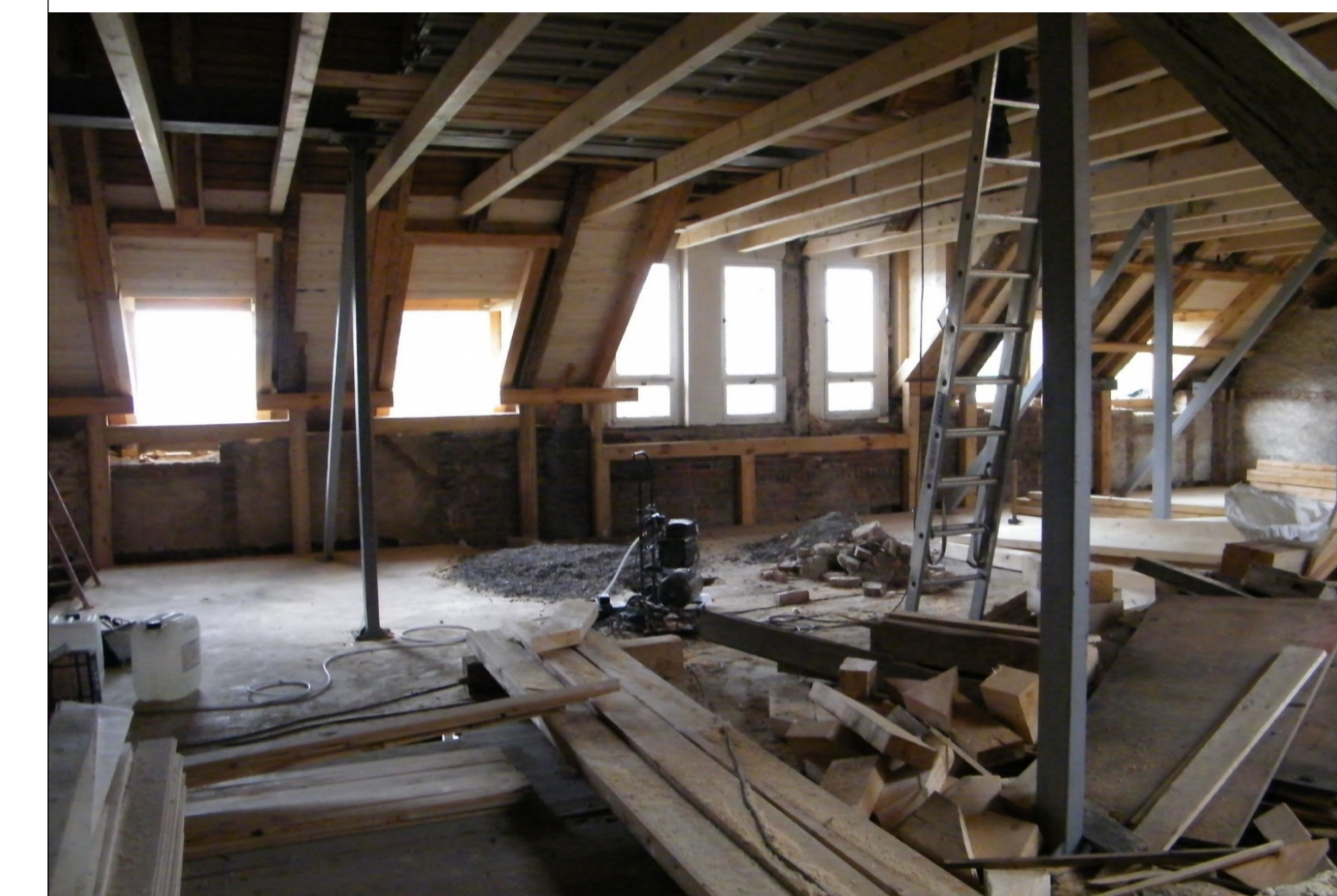
Zimmerarbeiten und Dachdeckung
