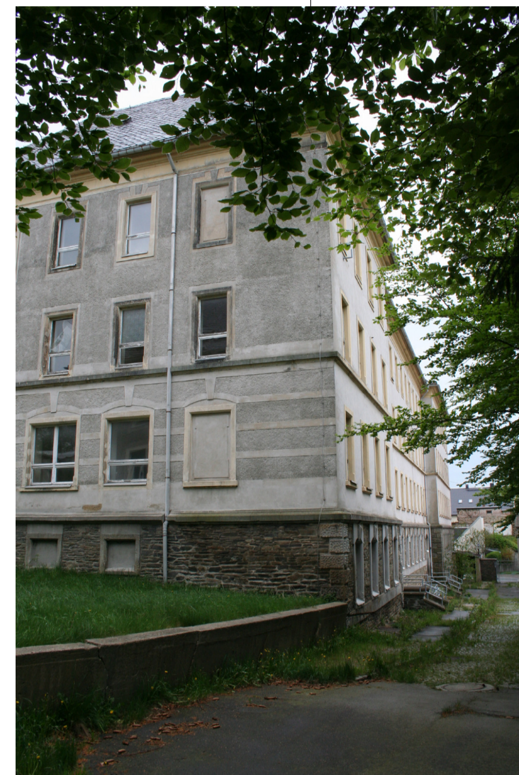
Gebäude vor Sanierungsbeginn
