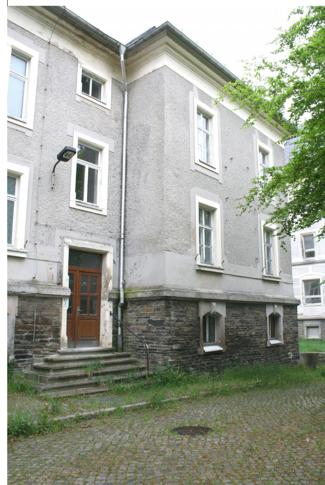
Gebäude vor Sanierungsbeginn
