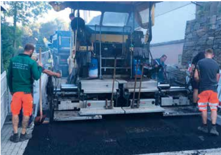
In der letzten Augustwoche erfolgte der Asphaltsteinbau
