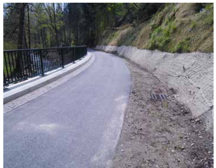
Im Anschluss wurde die Straße mit Asphalt wiederhergestellt
