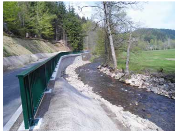
Blick auf die 45 m lange Stützmauer
