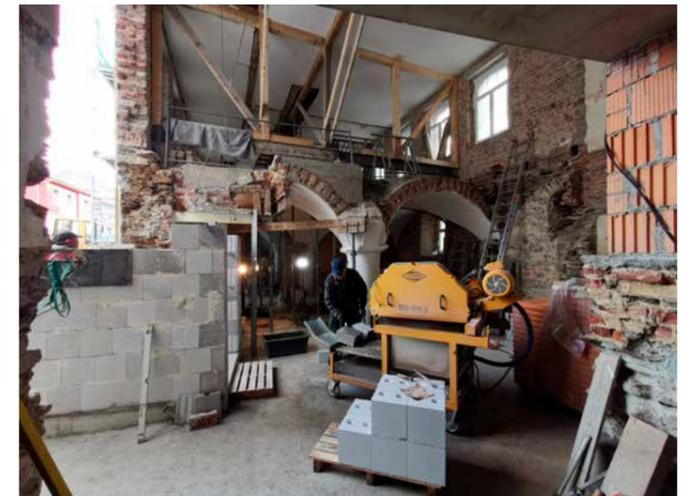
Beginn der Errichtung des Aufzugschachtes im entkernten Treppenhausbereich
