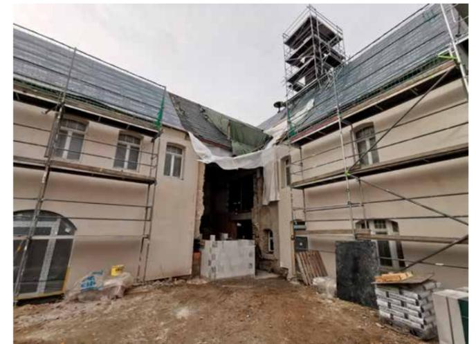
Blick vom Hinterhof zum entstehenden Aufzugschacht sowie auf den eingerüsteten Turm
