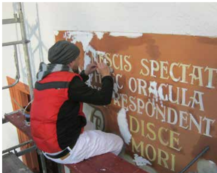
Zunächst erfolgte die denkmalgerechte Reinigung der Bilder
