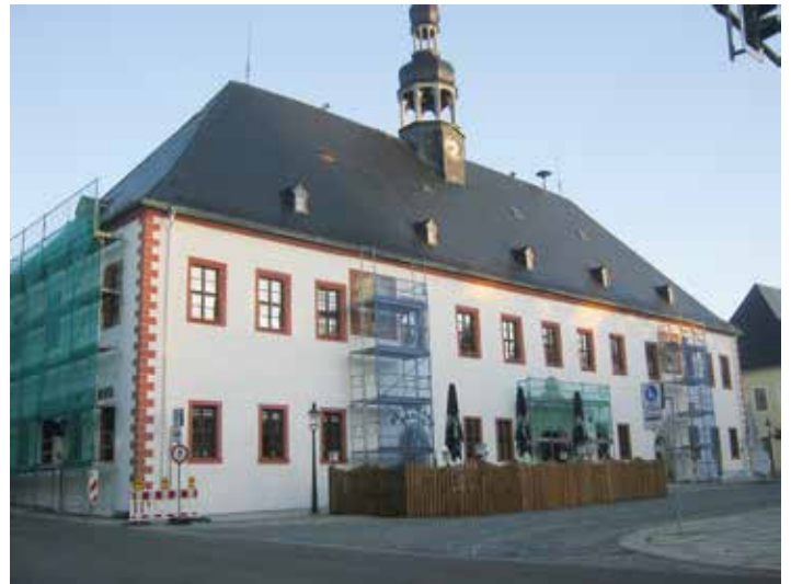
Die Dachdeckerarbeiten am Gebäude sind bereits abgeschlossen und die Sanierung der Fassade ist an der Rückseite des historischen Rathauses in den letzten Zügen.
