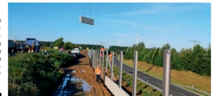
Einheben der Betonsockelplatten zwischen die Stahlträger, Foto: Bauer Tiefbauplanung GmbH
