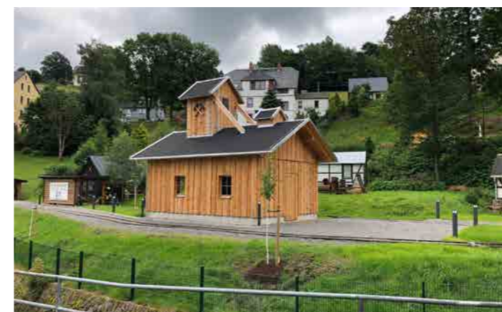
Die neue Nachbildung der Schachtkäue mit Fördereinrichtung ist ein Blickfang auf dem Gelände.
