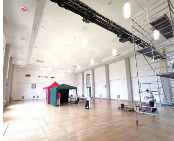
Blick in die frisch gestrichene Halle kurz vor Abschluss der Malerarbeiten
