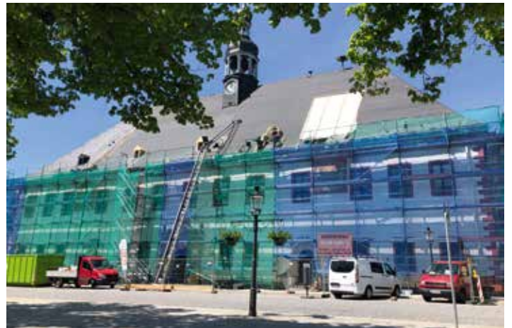
Erneuerung der Dachgauben im Mai 2020
