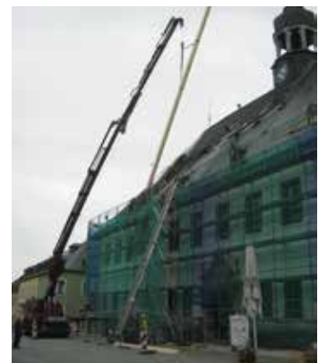
Mit Hilfe eines Kranes wurde ein 13 Meter langer Holzbalken eingesetzt
