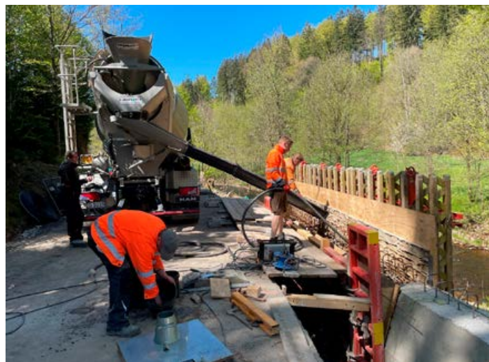
Betonage des Wandschaftes Segment 34 im 3. Wandabschnitt
