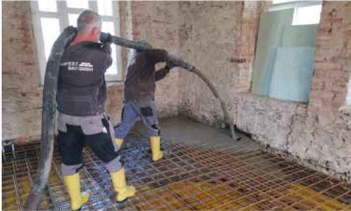
*Betonage der Stahlbetondecke*
