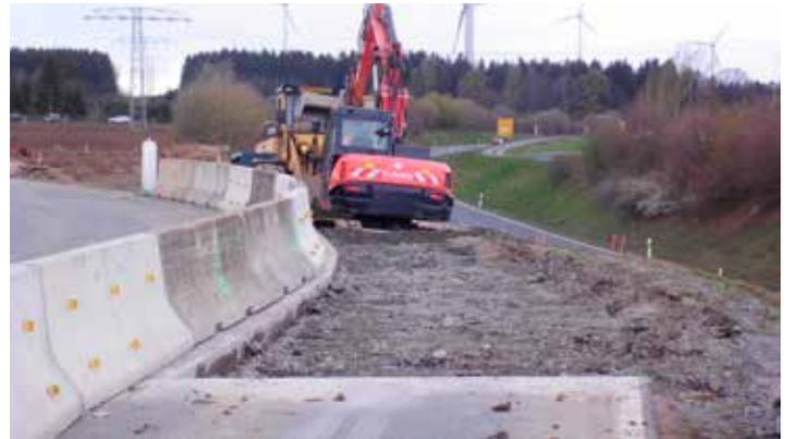
Die Kreisstraße 8131 musste teilweise abgetragen werden, um ein bei dem Bau der Lärmschutzwand störendes 30 kV-Kabel weiter in Richtung des Straßenkörpers der Kreisstraße zu verdrücken.
