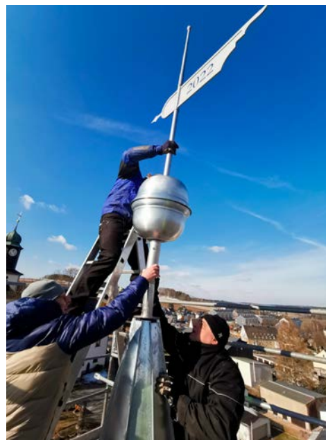
Schmied Albrecht Morgenstern gemeinsam mit den Mitarbeitern bei der Montage der neuen Turmbekrönung
