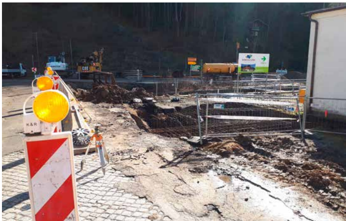
Altes Brückenbauwerk links mit Stahlträgerkonstruktion, rechts daneben ist der zukünftige Standort der Behelfsbrücke zu sehen
