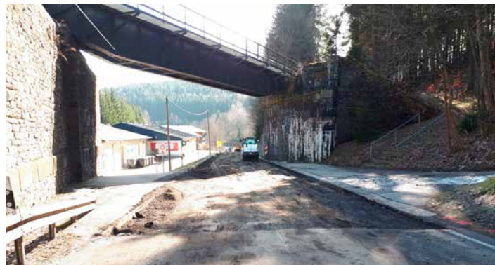
Offengelegter Straßenunterbau der B 171 am Beginn des Baufelds
