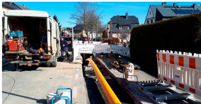
Verlegearbeiten der Gas-Mitteldruckleitung in den Straßenkörper
