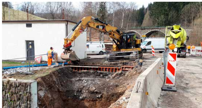
Betonierarbeiten am Widerlager der Behelfsbrücke
