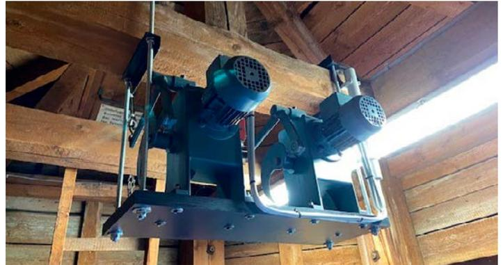
Mittels dieser Motoren erfolgt nunmehr die Glockensteuerung
