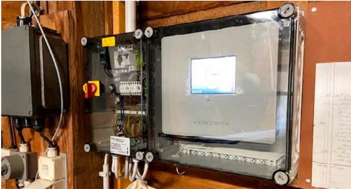
Steuerung und Schaltkasten zur Signalverstärkung wurden neu eingebaut
