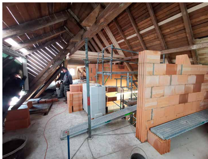
Mauerung der Treppenhauswände im Dachgeschoss
