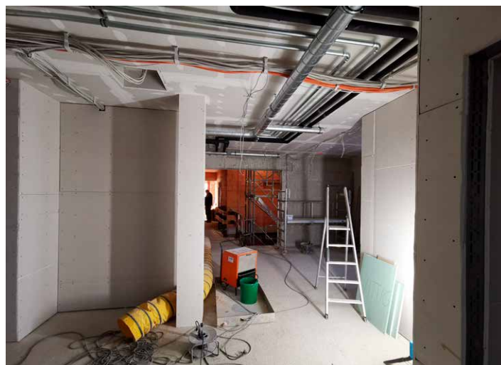
Sanierungsstand im Obergeschoss, Bereich Arztpraxis
