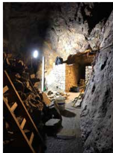
Verkleidung der Weitung im Mathias-Morgen-Gang
