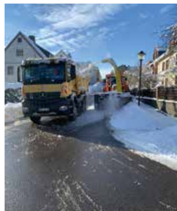
Fräsarbeiten in der Töpferstraße
