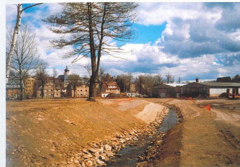
Die Offenlegung des Moosbaches
