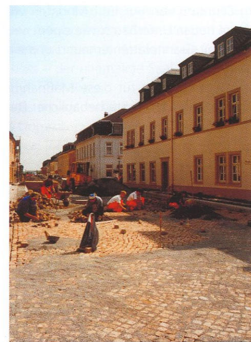
Während der Pflasterarbeiten
