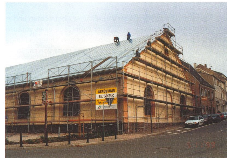
Während der Dachsanierung
