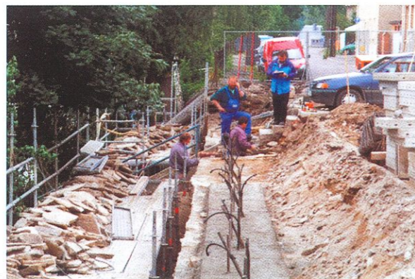
Während der Bauarbeiten
