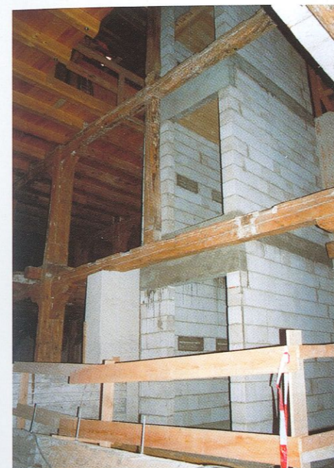
Der Fahrstuhlschacht im Innenbereich
