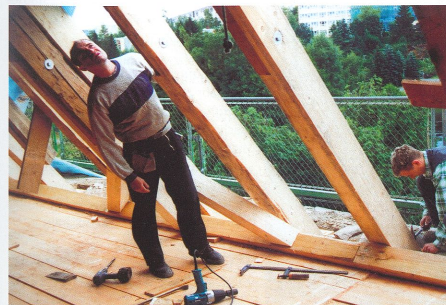
Arbeiten am neuen Balkenwerk
