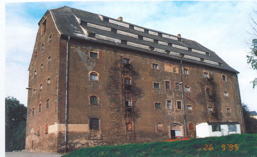
Das Bergmagazin vor der Sanierung
