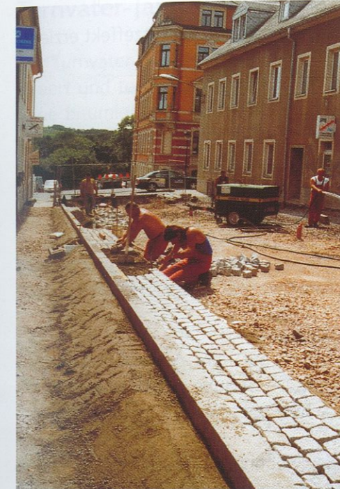
Pflasterarbeiten an den Rinnsteinen
