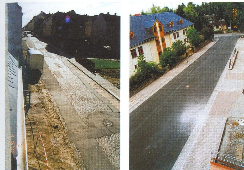
Der 1. Teilabschnitt der Töpferstraße vor und nach der Baumaßnahme
