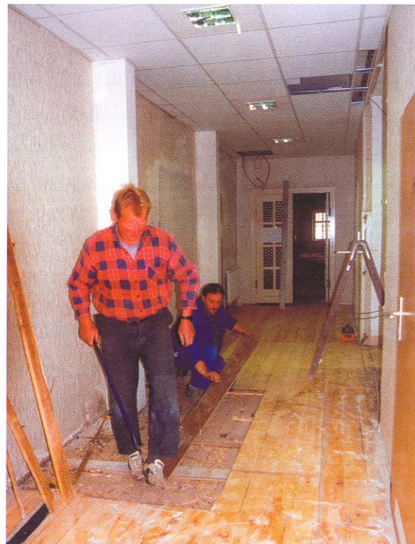
Abbruch der alten Dielung
