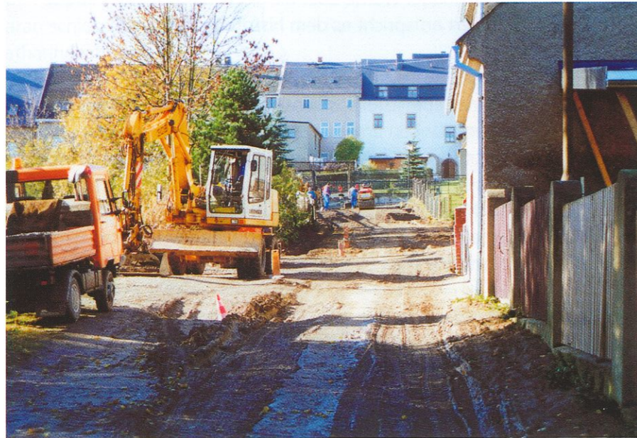
Während der Bauarbeiten
