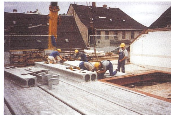
Verlegen der Stahlbetondeckenplatten
