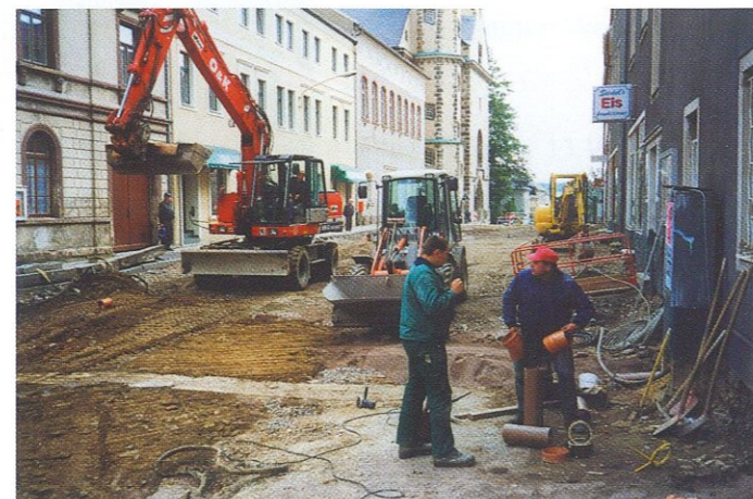
Die Herzog-Heinrich-Straße vor dem Ausbau und während der Bauarbeiten
