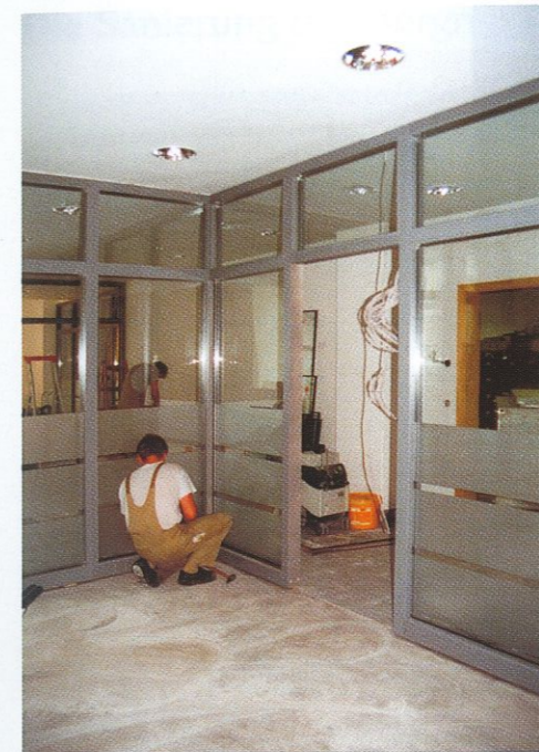
Einbau der Glaszwischenwände
