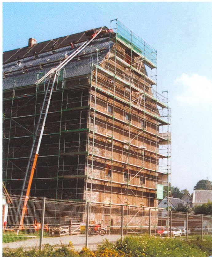
Während der Dachdeckerarbeiten
