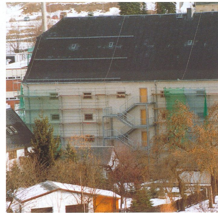
Die fertig gestellte Fluchttreppe an der Hinterfront
