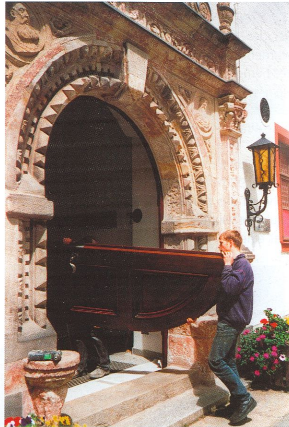
Einbau der neuen Tür
