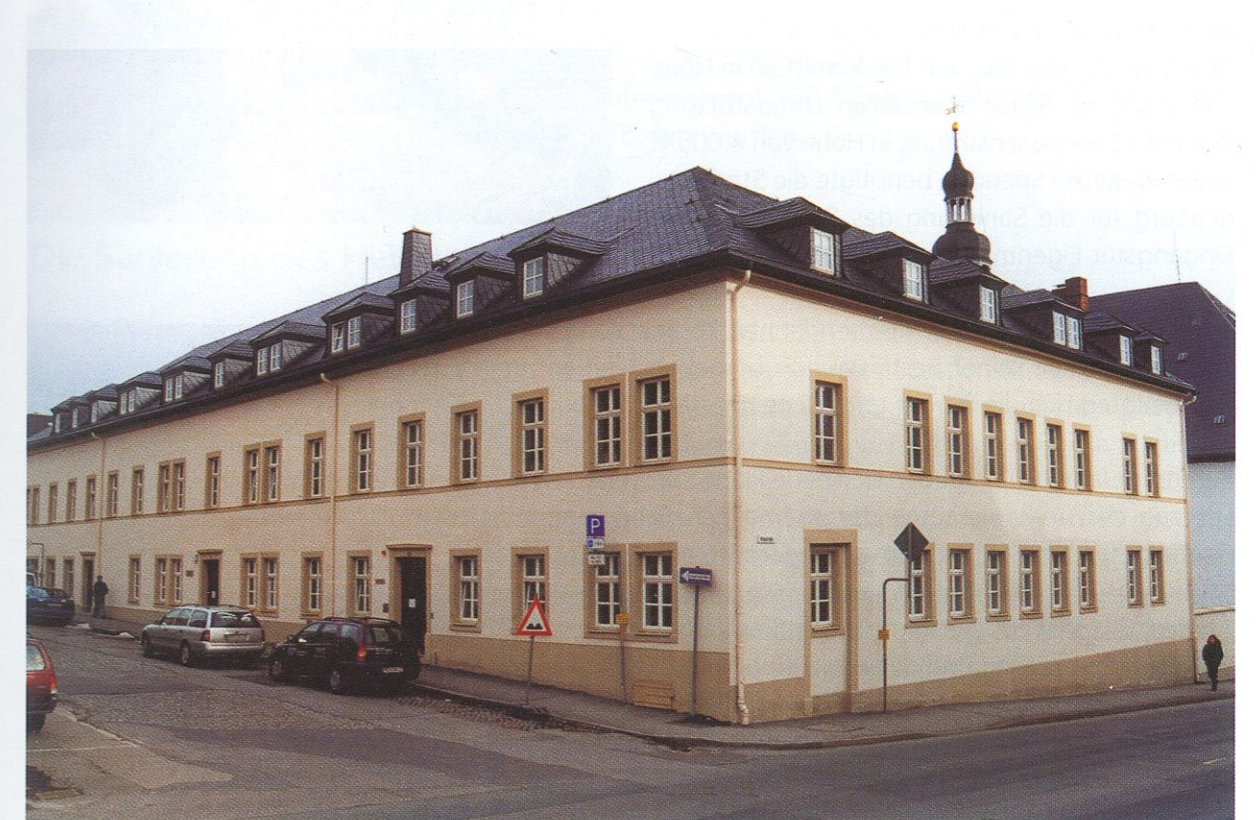
Das fertig gestellte Rathaus im Bereich der Töpferstraße
