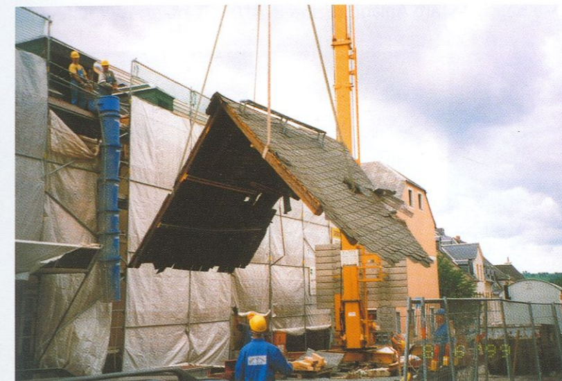
Demontage des alten Dachtragwerkes
