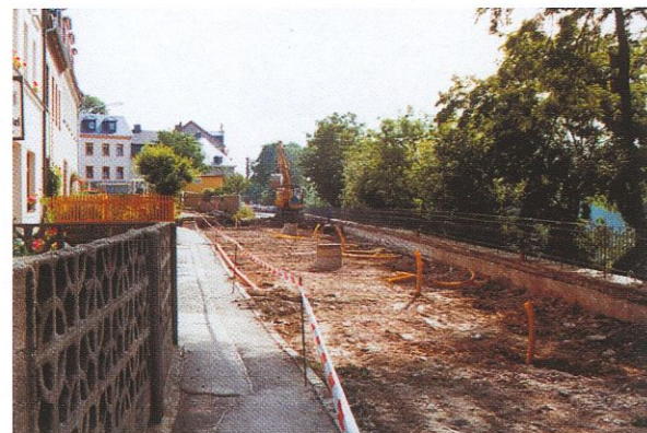
Während der Bauarbeiten auf dem 1. Bauabschnitt
