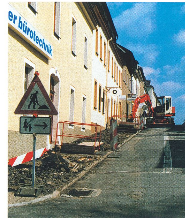
Im April 1998 wurde der Fußweg entlang der Scheffelstraße erneuert.
