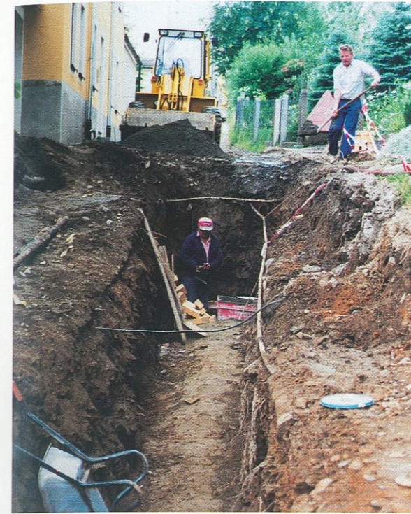
Während der Bauarbeiten
