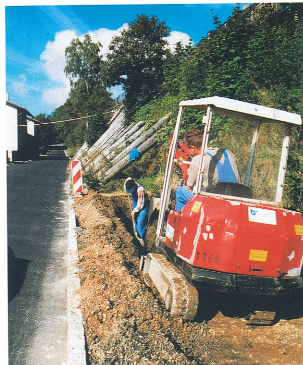
Ein neuer Fußweg wird angelegt
