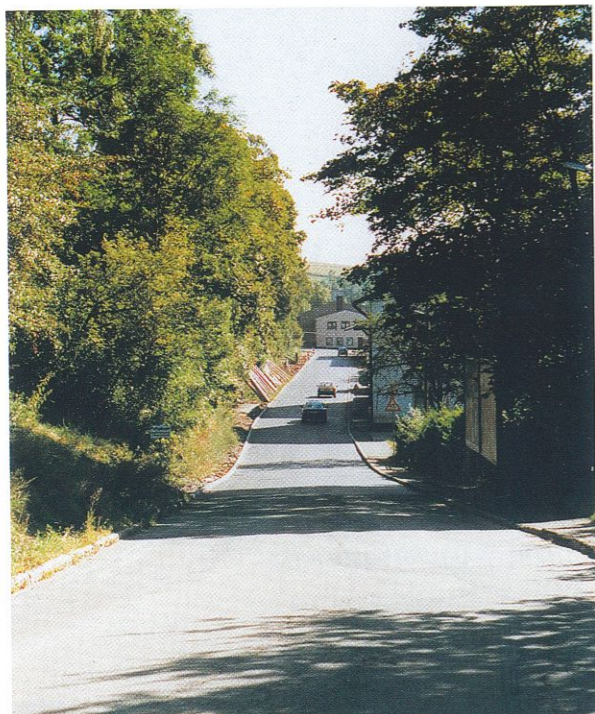
Die Untere Bahnhofstraße nach Aufbringung der neuen Straßendecke
