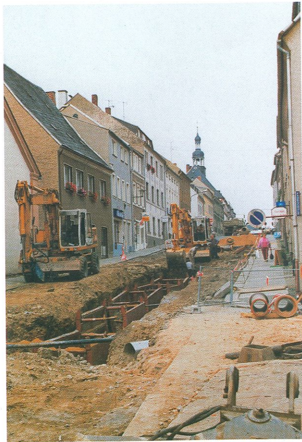
Kanalauswechslung in der Wolkensteiner Straße
