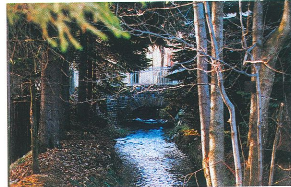
Die Brücke nach Baufertigstellung
