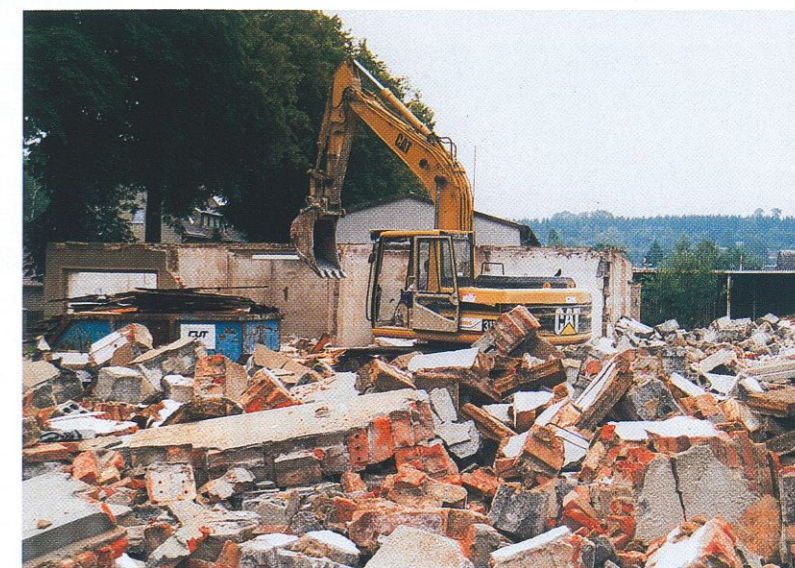
Abriss der Garagen
