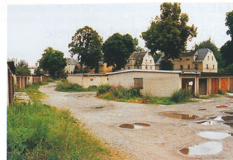
Bestand Garagenkomplex an der Hanischallee
