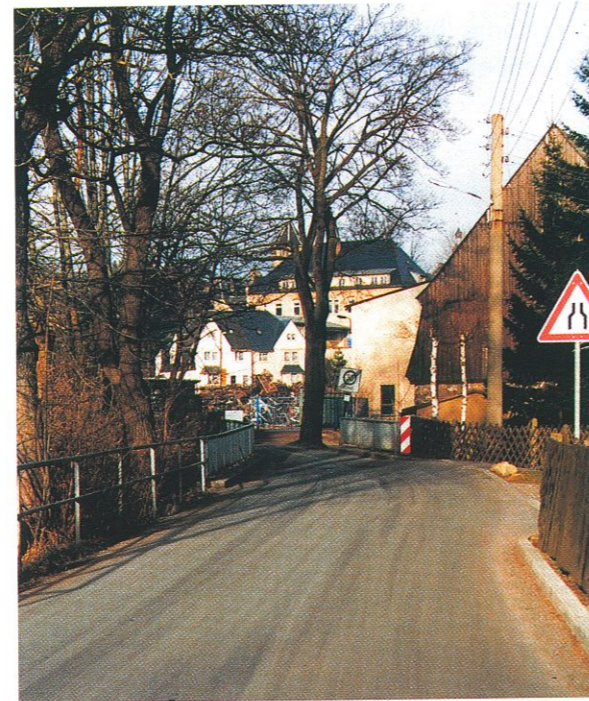
Ein Teilabschnitt der Dr.-Wilhelm-Külz-Allee nach der Deckenerneuerung
