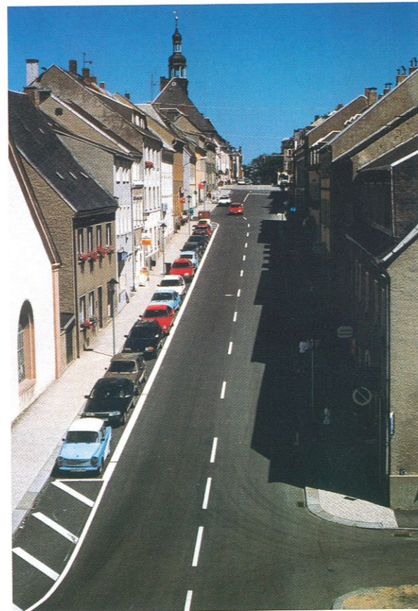
Nach Fertigstellung der Baumaßnahme
