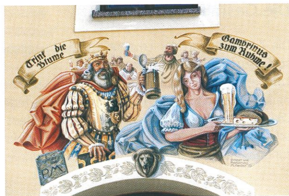
Fassadengestaltung nach historischem Befund am Gebäude Kirchstraße 42
