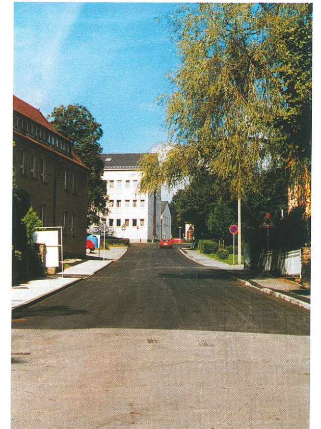
Der 2. Teilabschnitt nach Baufertigstellung
