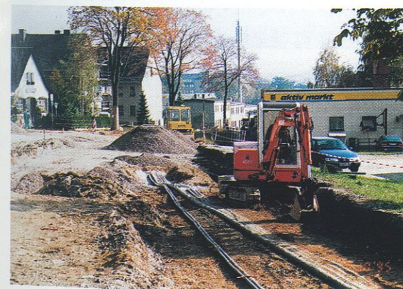
Bei der Verlegung der Telekomleitungen und Leitungen für die Straßenbeleuchtung
