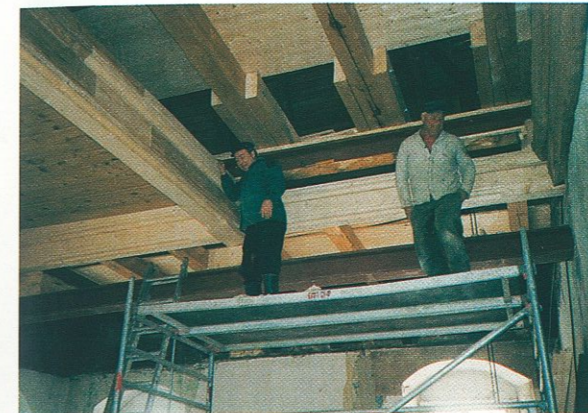
Detailaufnahme von der Holzbalkendecke während den Einbauarbeiten
