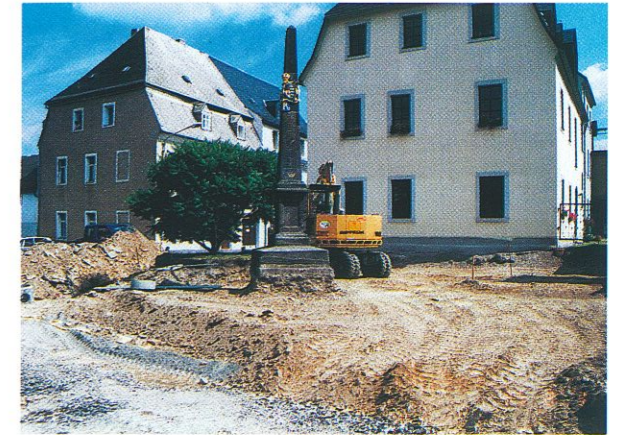
Während der Bauphase
