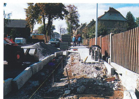
Pflasterarbeiten am neuen Gehweg
