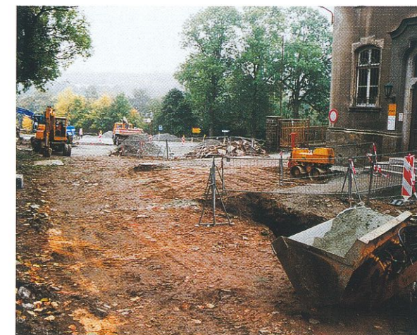
Bauarbeiten an der Kreuzung B 171/B 174
