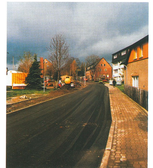
Nach Aufbringung der bituminösen Deckschicht
