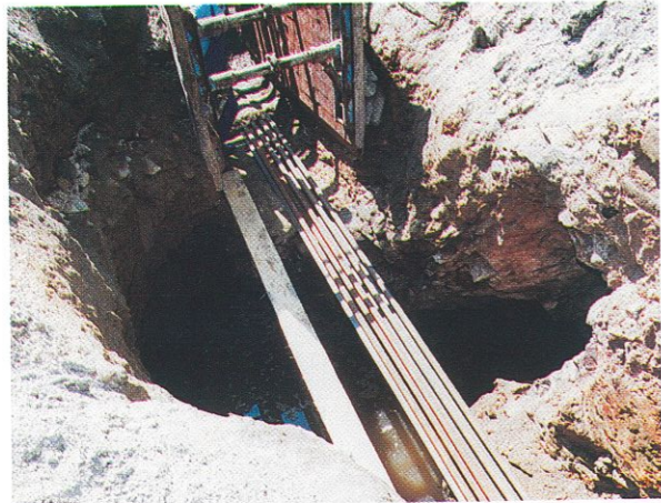
Erkundungs- und Sicherungsmaßnahmen am Altbergbau
