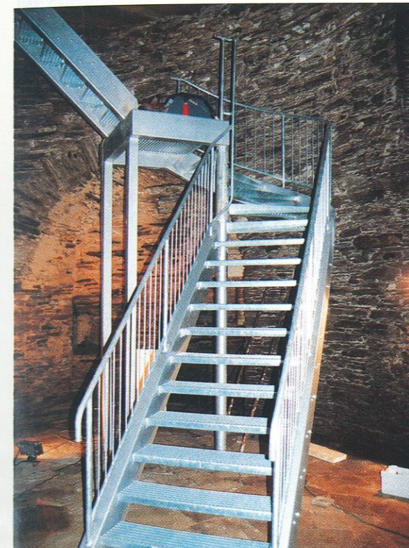
Die neuen Treppen
