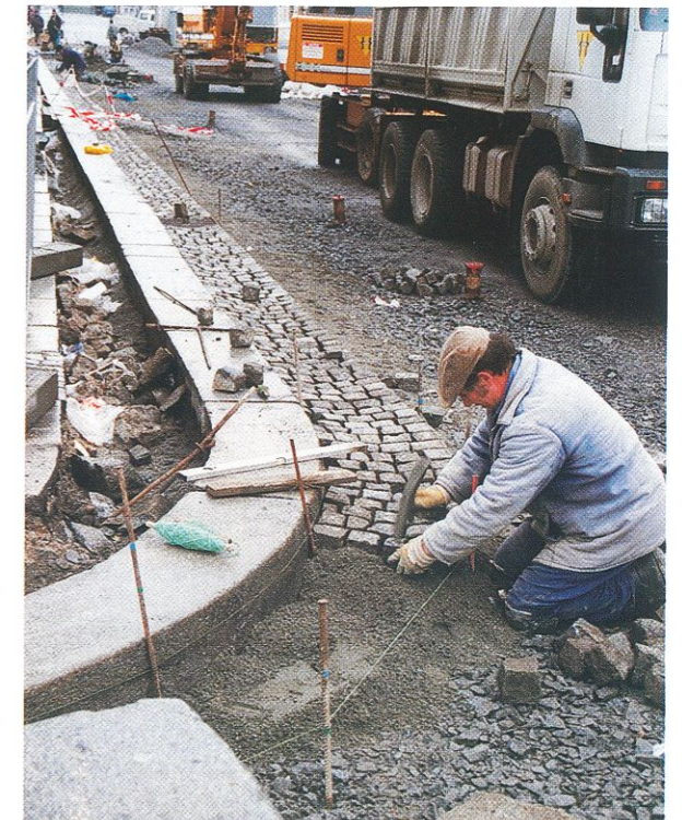
Während der Bauarbeiten im 2. Bauabschnitt
