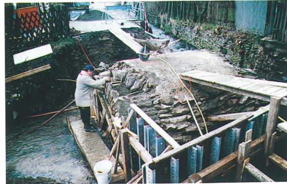
Maurerarbeiten an der Natursteinbrücke
