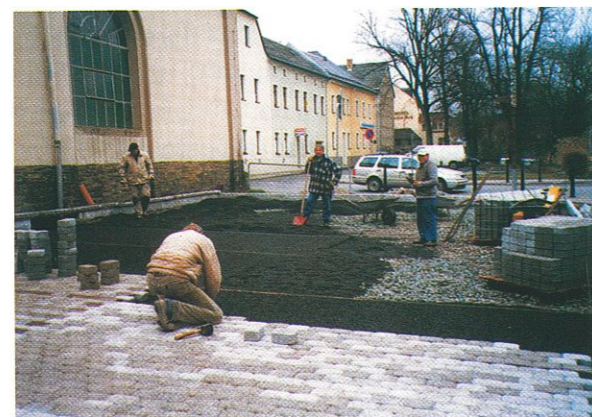
Bei den Pflasterarbeiten im Außenbereich
