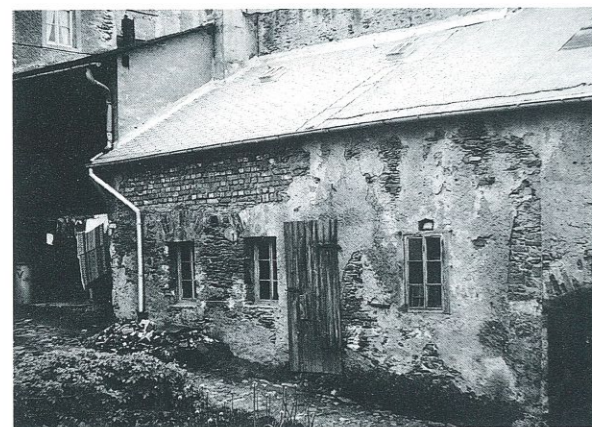
Blick in den Innenhof des Gebäudes Zschopauer Straße 20
