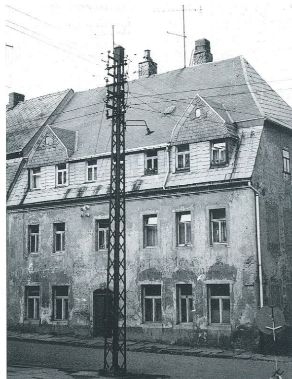
Ansicht des Gebäudes Kirchstraße 30
