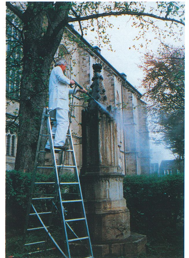
Herr Richert bei den Entsalzungsarbeiten
